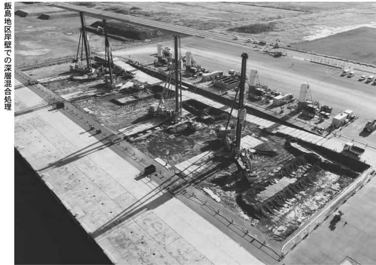
飯島地区岸壁での深層混合処理
