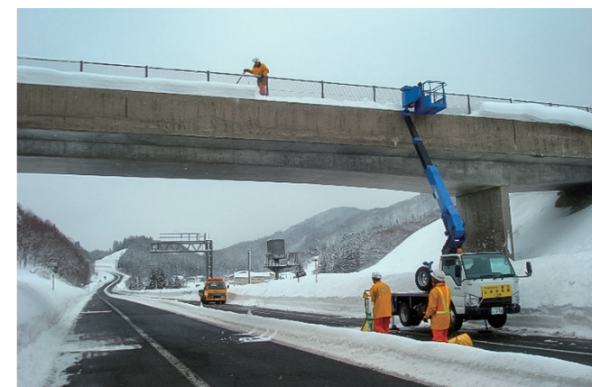
■跨道橋の雪底処理作業
