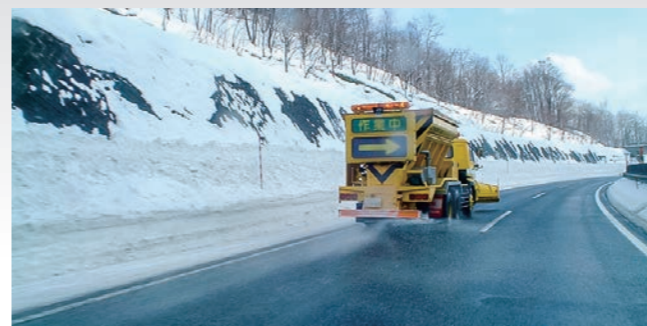
■凍結防止剤散布作業
