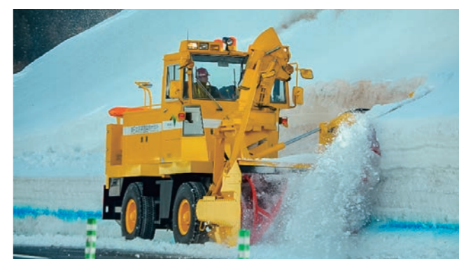
■路肩雪底切り作業
