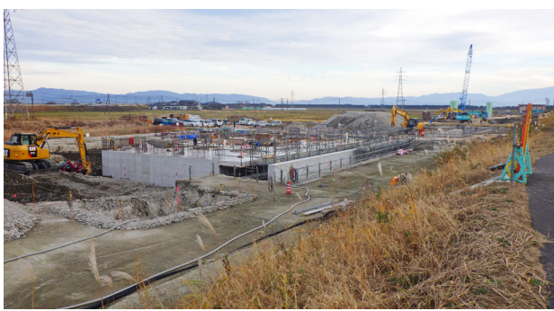
躯体構築が進む吸込水槽。現場では外国人技能者も活躍している
