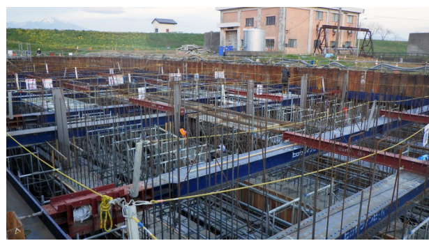
品質にも配慮しながら施工中。写真奥が現在の機場
