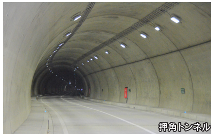
押角トンネル
