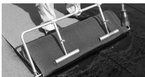
アスファルト防水熱工法の「信頼性」と改質アスファルト防水粘着工法の「環境親和性」を組み合わせた環境配慮型改質アスファルト防水工法です。アスファルト溶融釜を使用せず、下層ルーフィング表面を専用工具(マルチローラー)を併用して炙り、溶け出した易溶融性改質アスファルトを防水材接着剤として使用することで、従来の熱工法と同様の防水効果(性能)を発揮しつつ、安全且つ省力化を実現しています。
