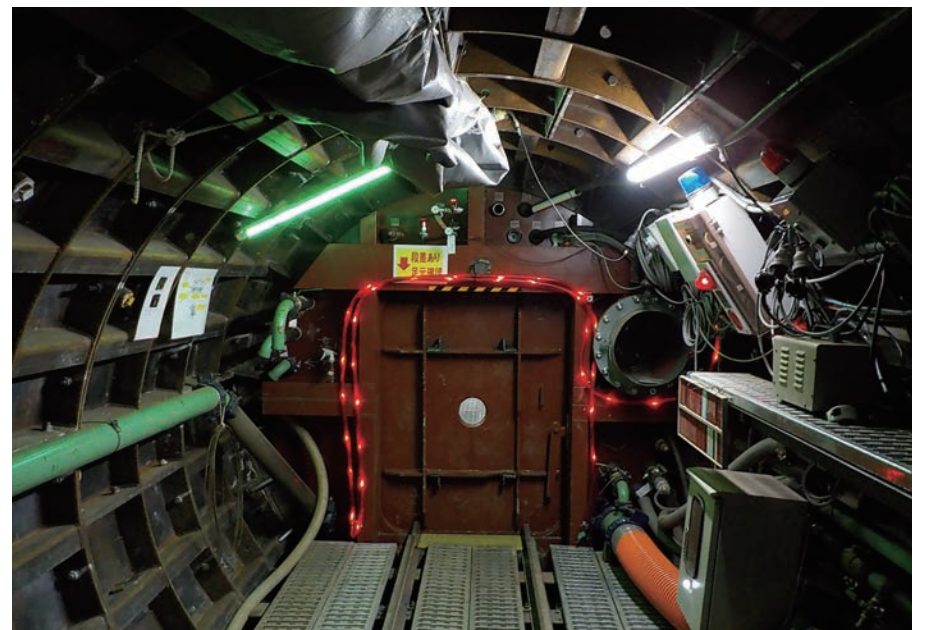
シールド内部（隔壁設置部）
