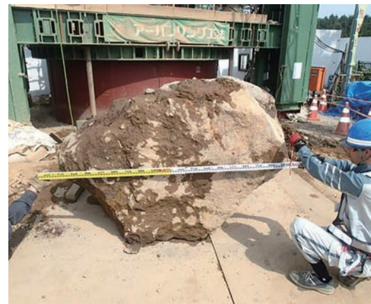
地中から出てきた巨石（左）と岩塊多く地層により削れたカッターヘッドの面板（上）
