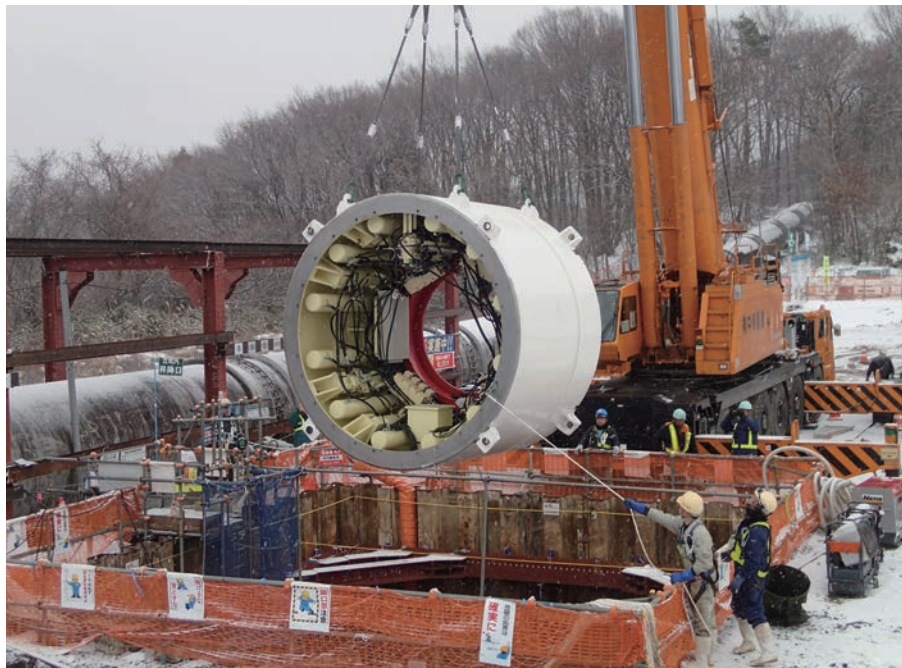
東側の発進立坑から5分割にしたシールドマシン投入の様子（2018年12月）
