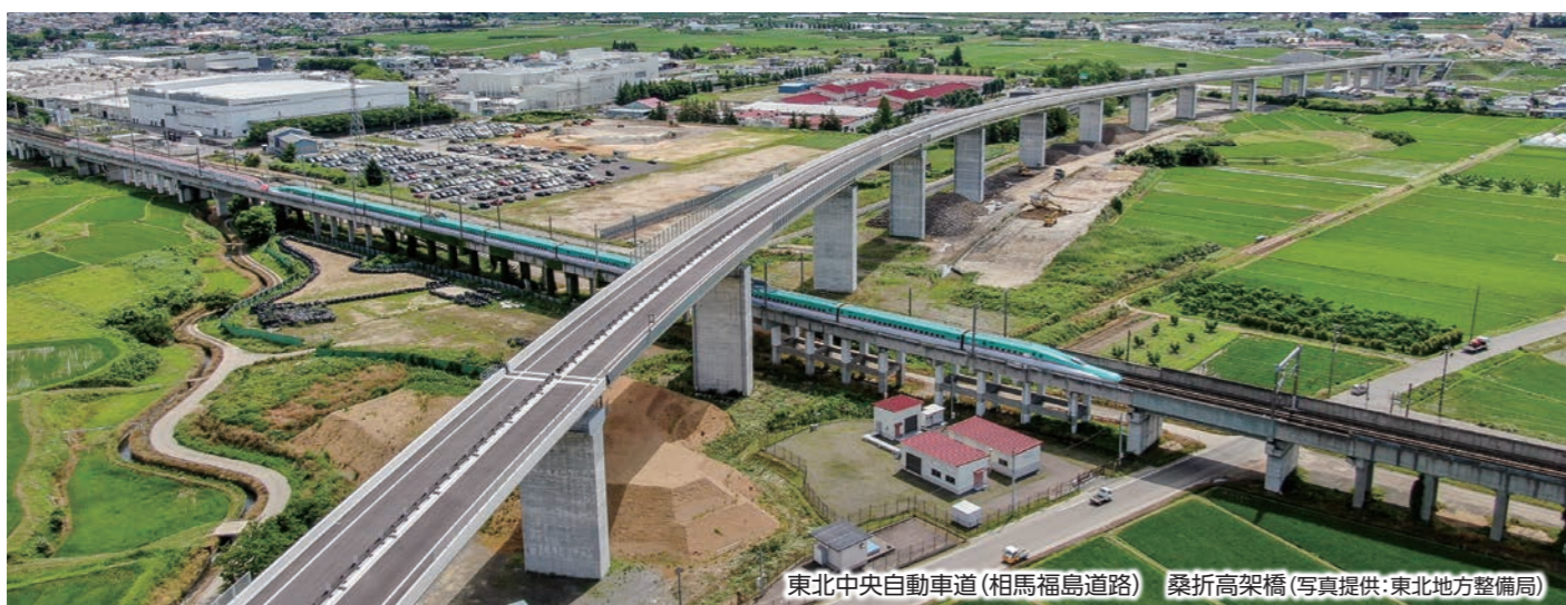
東北中央自動車道(相馬福島道路) 桑折高架橋 (写真提供:東北地方整備局)
