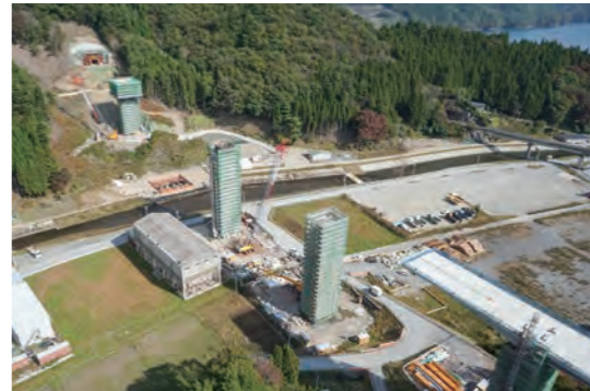
吉浜釜石道路の部分工区での大ロット工事。3.2kmという比較的短い区間にトンネル3基、高架橋2橋の大型構造物が連続した。写真＝施工中の片岸高架橋。前年夏に貫通した片岸トンネル出口が見える。2015年10月22日
