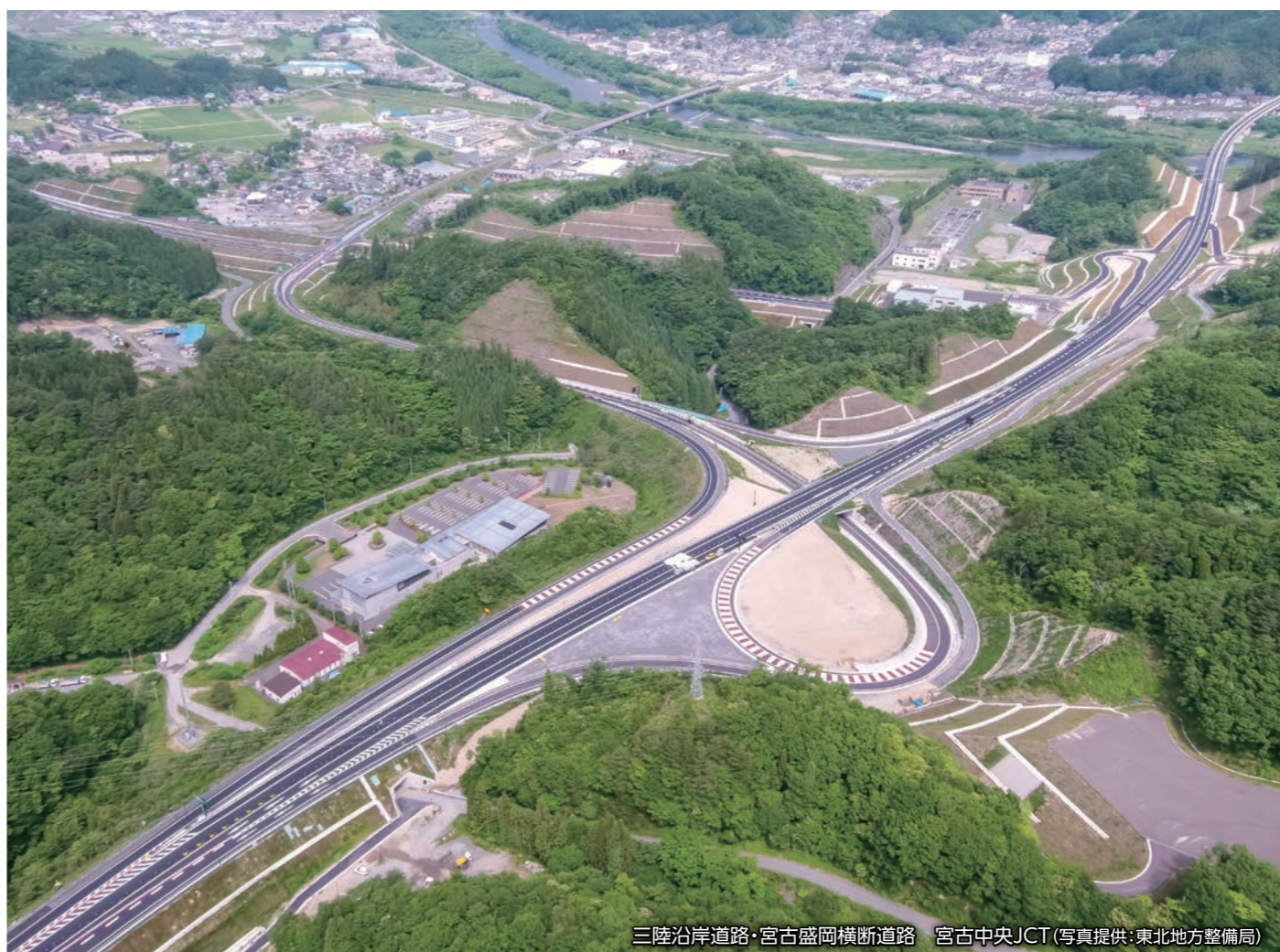
三陸沿岸道路・宮古盛岡横断道路 宮古中央JCT (写真提供:東北地方整備局)
