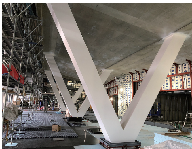
エントランスに設置しているV字柱
