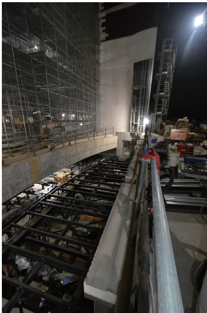
大ホールの舞台装置（オーケストラピット）
