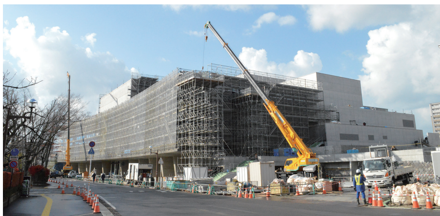
秋田市立中央図書館明德館前から見た現場（2021年11月施工時）
