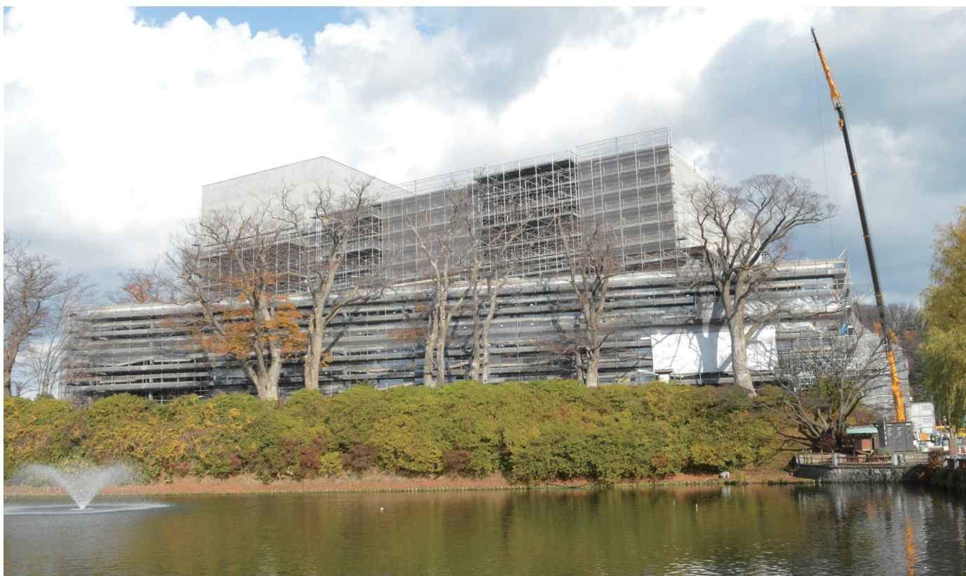
お堀を挟んで南側から見た外観（2021年11月施工時）
