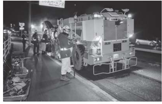
施工現場の様子
