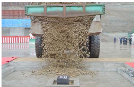
自動化された建機で礎石を埋納
