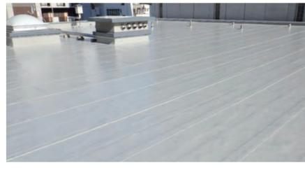
改質アスファルトルーフィングを、ルーフィング裏面の粘着によって、下地に張付ける環境配慮型改質アスファルト防水工法です。ルーフィングの仕上げをストレート砂に替えて高耐候性フィルムとすることで、意匠性に優れた仕上げが可能です。
