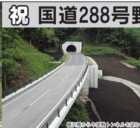
楓沢橋から中屋敷トンネルを望む
