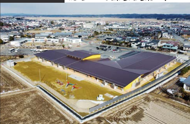
建築工事部門 若柳地区幼保連携型認定こども園建設建築工事
