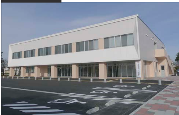
設備工事部門 若柳公民館建設電気設備工事
