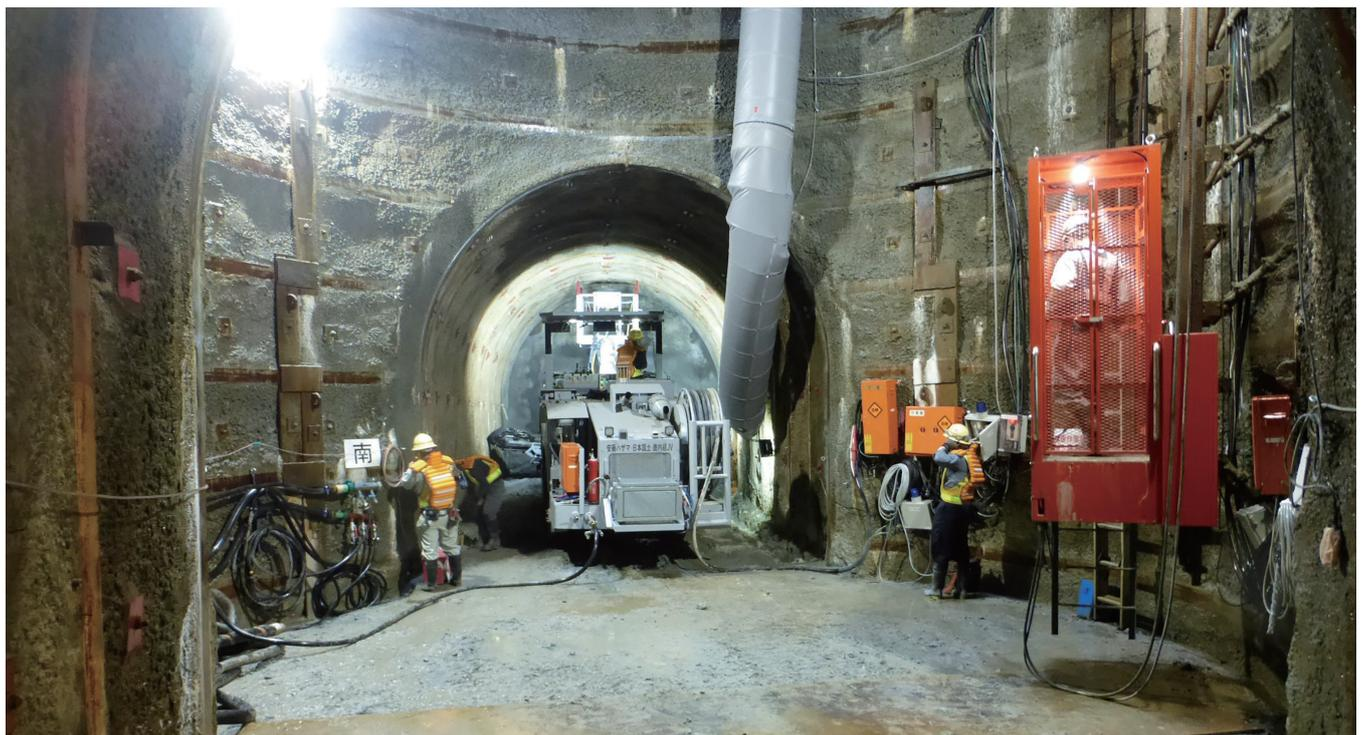
立坑の底部と奥に伸びる堤外仮排水トンネル（写真は安藤ハザマJV提供）
