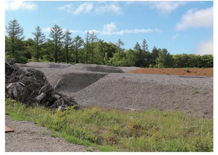
伐採したブナは破碎・チップ化してストックヤードに保管。腐食させた後、最終的には土捨場の表土にする
