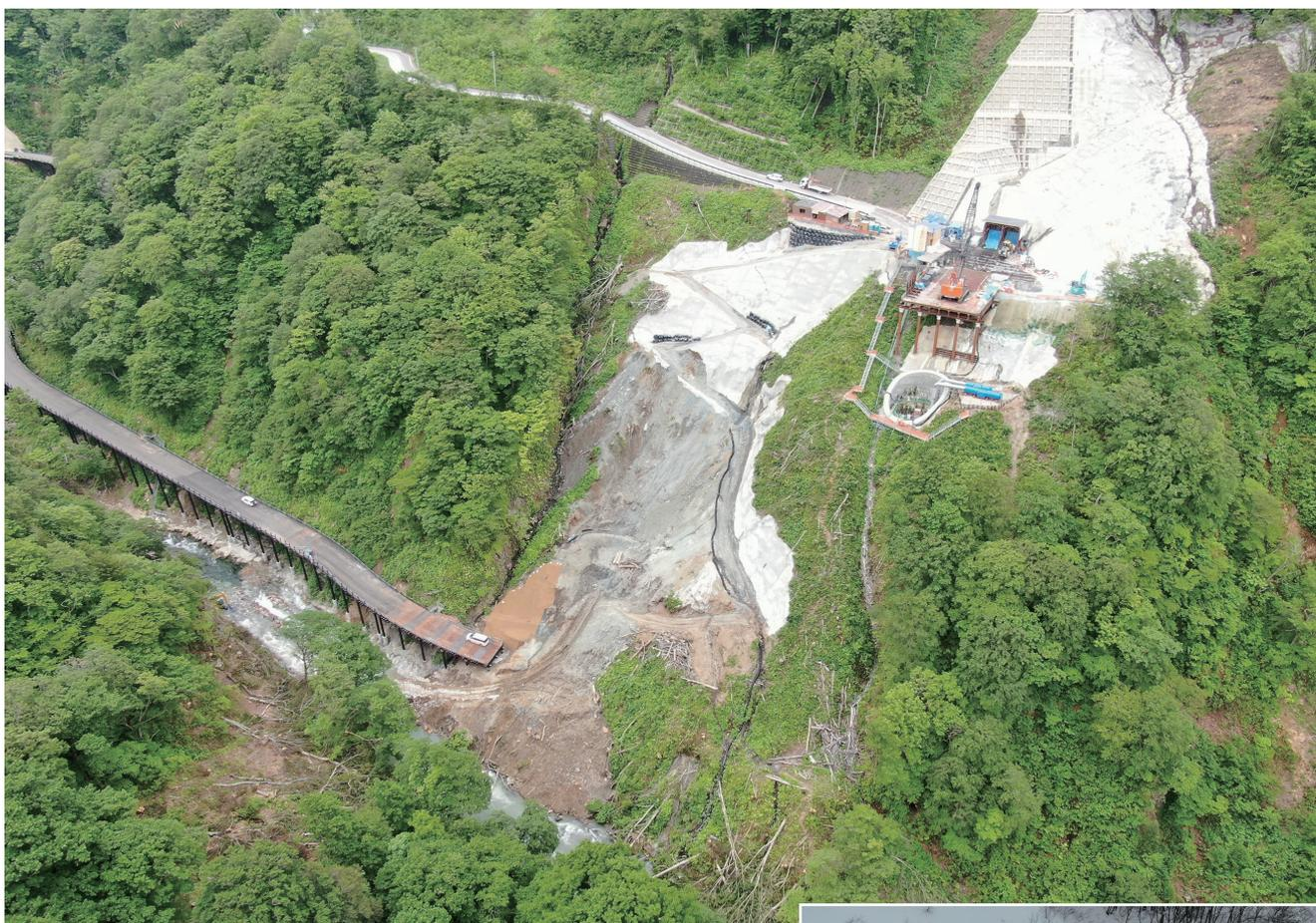
立坑坑口など転流工の全景。左側に伸びるのがダムサイトまでの4号工事用道路。下は同じく雪に覆われた4号工事用道路（いずれも写真は安藤ハザマJV提供）
