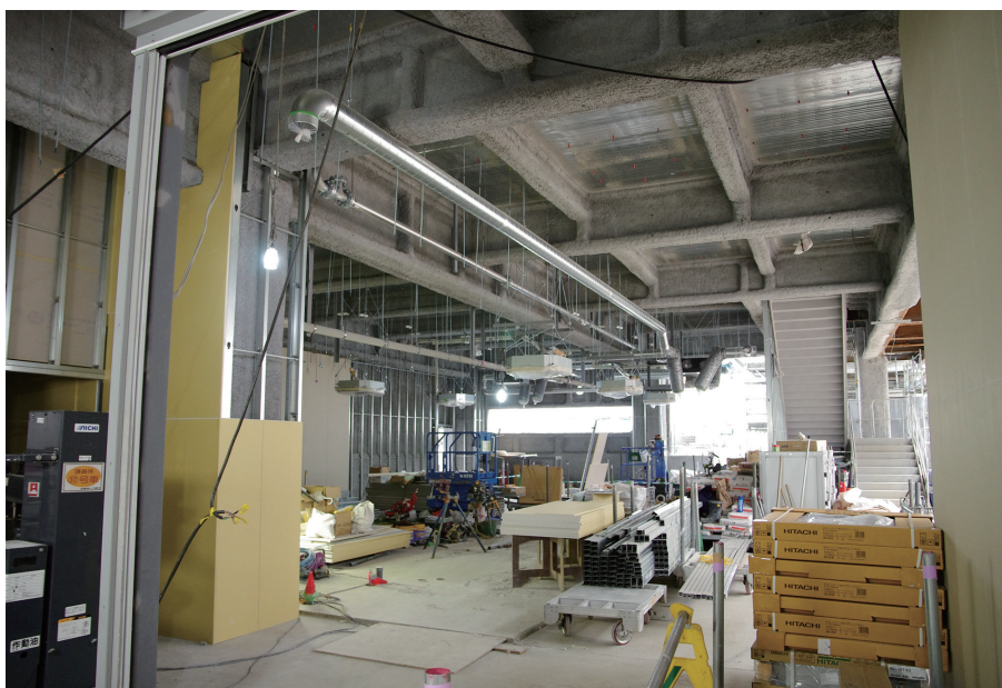
ヤードに使用していた講義棟は後から施工したため内部工事が急ピッチで進む
