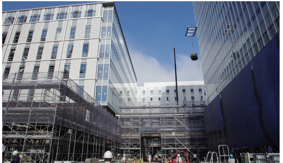
足場架設されている回廊部分が各棟をつなぐ
