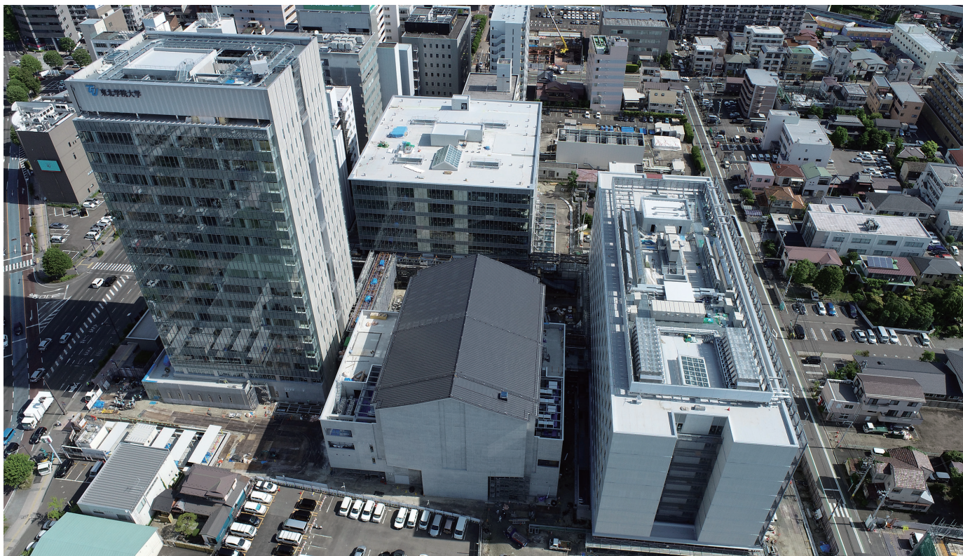
2022年5月末の施工状況（提供写真）
