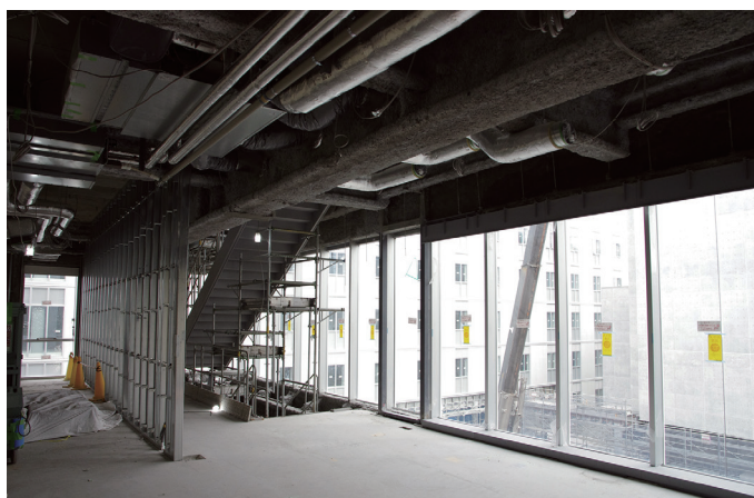
内部工事を進める講義棟
