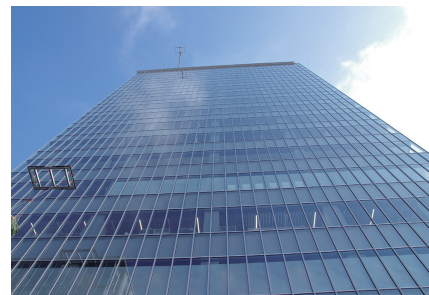
モノレール工法で施工した高層棟のカーテンウォール
