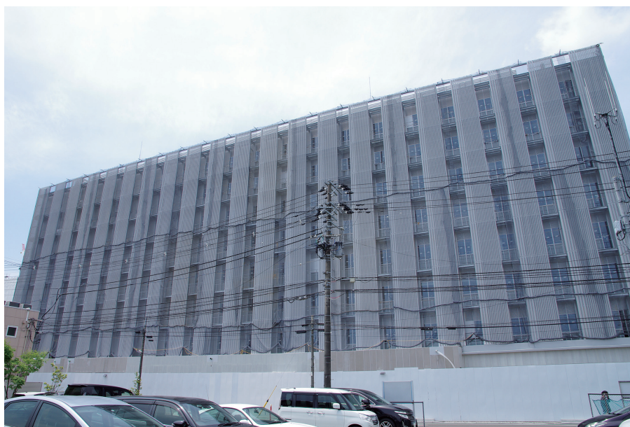
市道東七番町通側から見た研究棟
