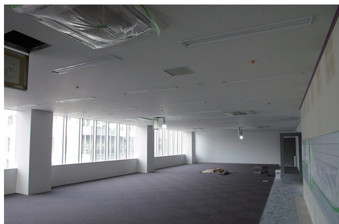
タイルカーペットの仕上げが進む高層棟の事務室
