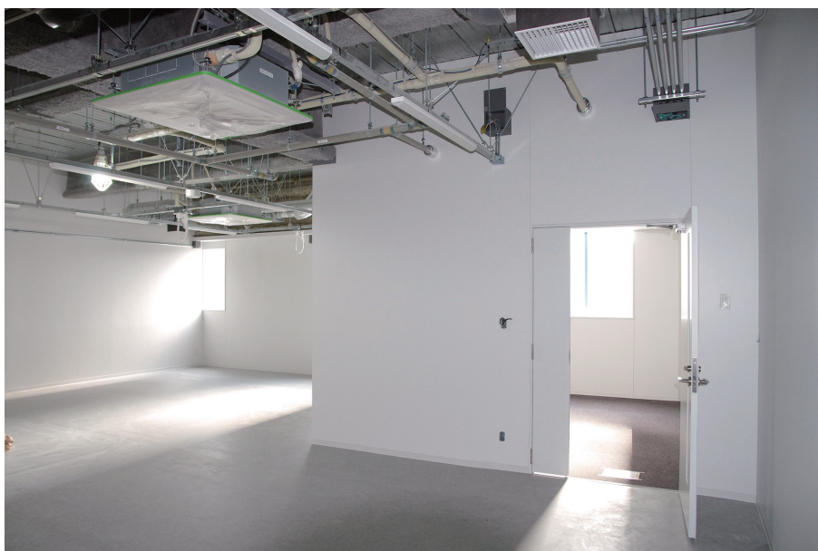
天井部の配管や吊りボルトも整然と仕上げられている
