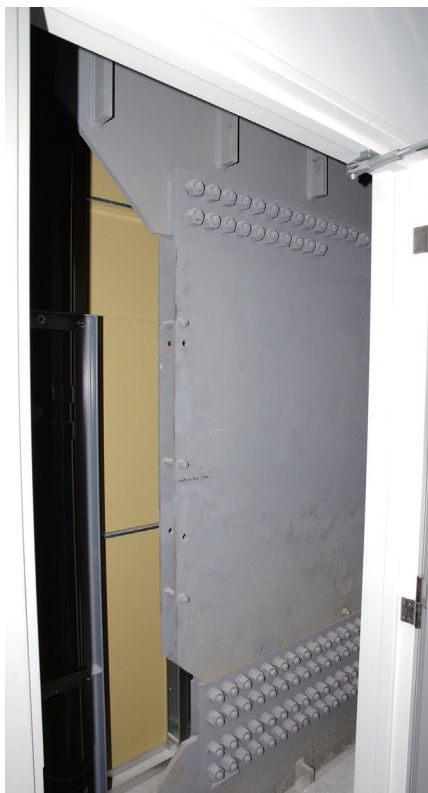
高層棟の制振装置
