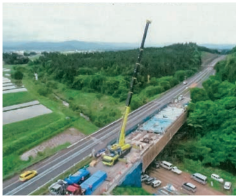
▲橋梁補修(床版取替)の状況
