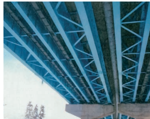
▲橋梁塗替塗装の状況
