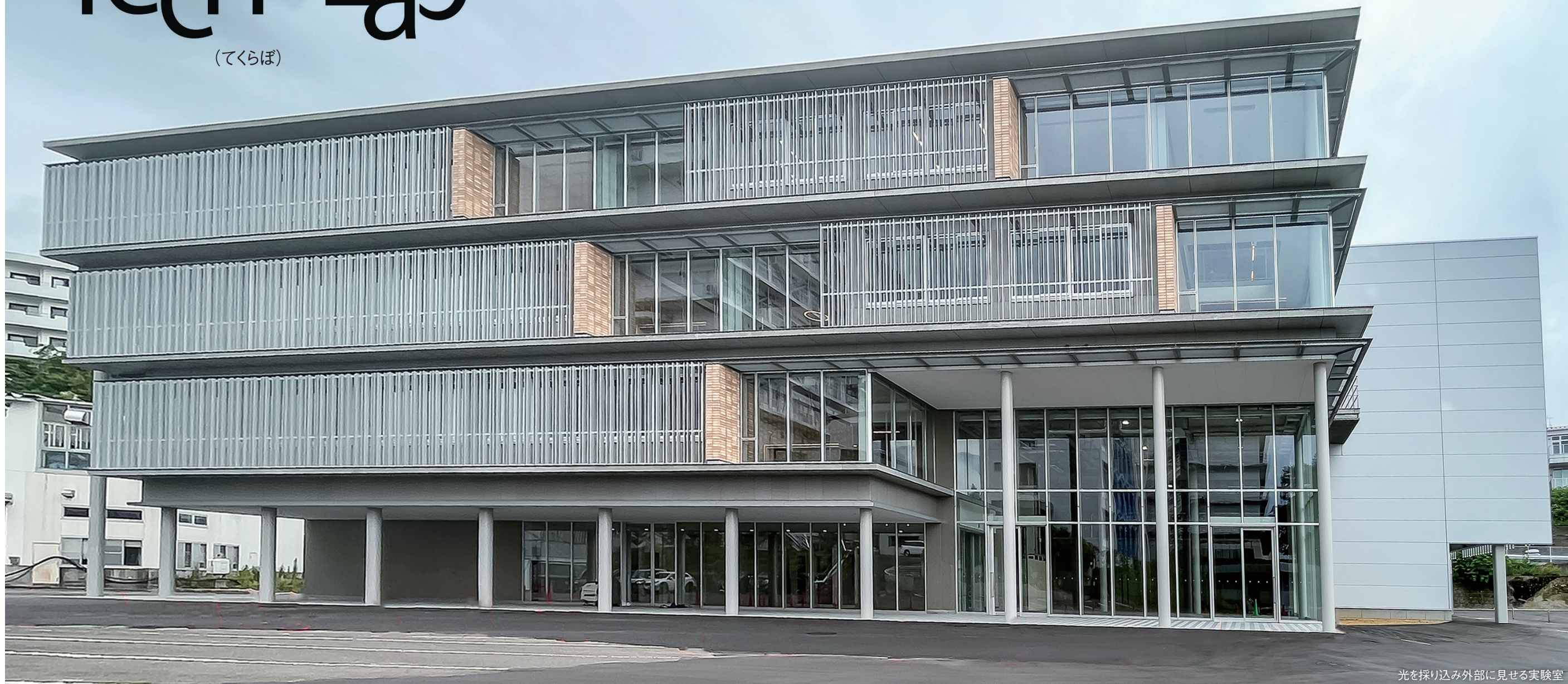
光を採り込み外部に見せる実験室
