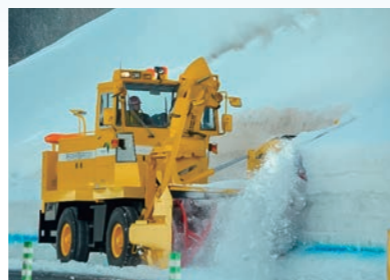
■路肩雪底切り作業
