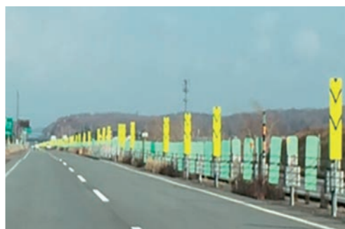
■中央分離帯の視線誘導灯(アイマーク)設置状況
