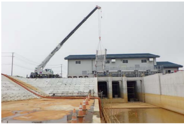
河南二期地区 中區機場(除塵設備据付状況)
