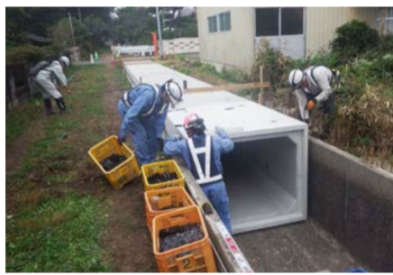
和賀中央地区 猿田幹線水路
