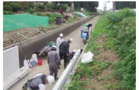
和賀中央地区 下堰幹線用水路
