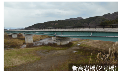
新高岩橋(2号橋)
