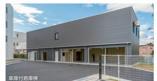
車庫付倉庫棟
