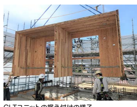
CLTユニットの据え付けの様子
