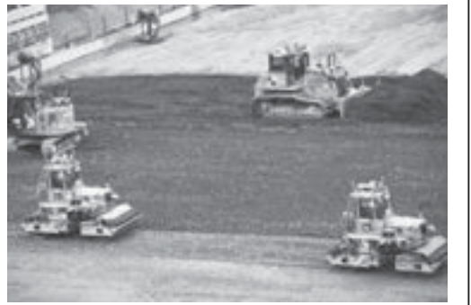
無人重機で施工が進む成瀬ダム建設現場
