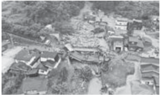
2021年8月豪雨で被災した青森県つ町の国道279号小赤川橋(提供:国土交通省東北地方整備局)
