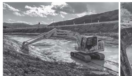
▲ICT機械による掘削・整地
