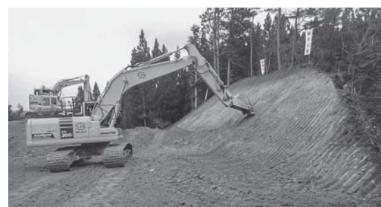
▲ICT機械による掘削・整地
