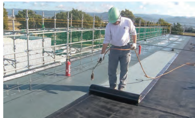
▲改質アスファルト防水
