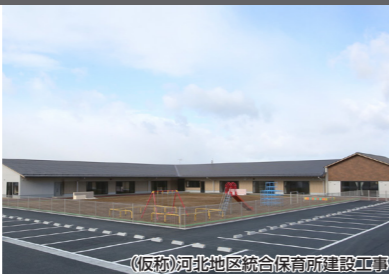
(仮称)河北地区統合保育所建設工事
