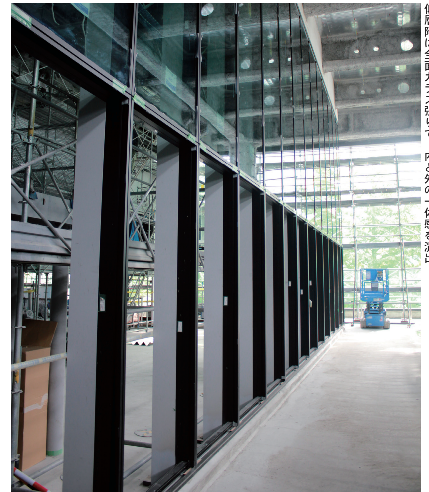
低層階は全面ガラス張り、内と外の一体感を演出
