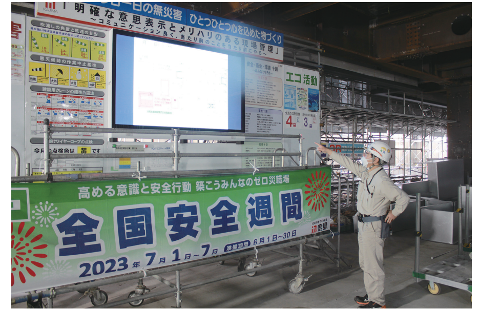
作業工程などを表示する安全掲示板はキャスターで動かすことができ、工程によって移動させる
