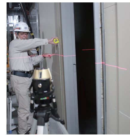
測定機のレーザー照射で正確な高さを測りながら工事を進める
