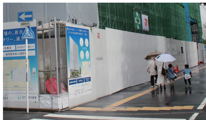
仮囲いの出隅部は透明パネルとし、内部に四季を感じるものを展示
