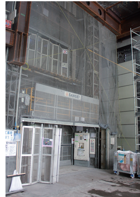
工事用エレベーターは、防音パネルと防音シート(写真右側)で囲い、二重の対策
