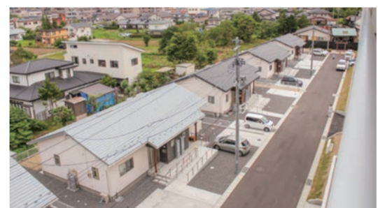
▲丸森町災害公営住宅
