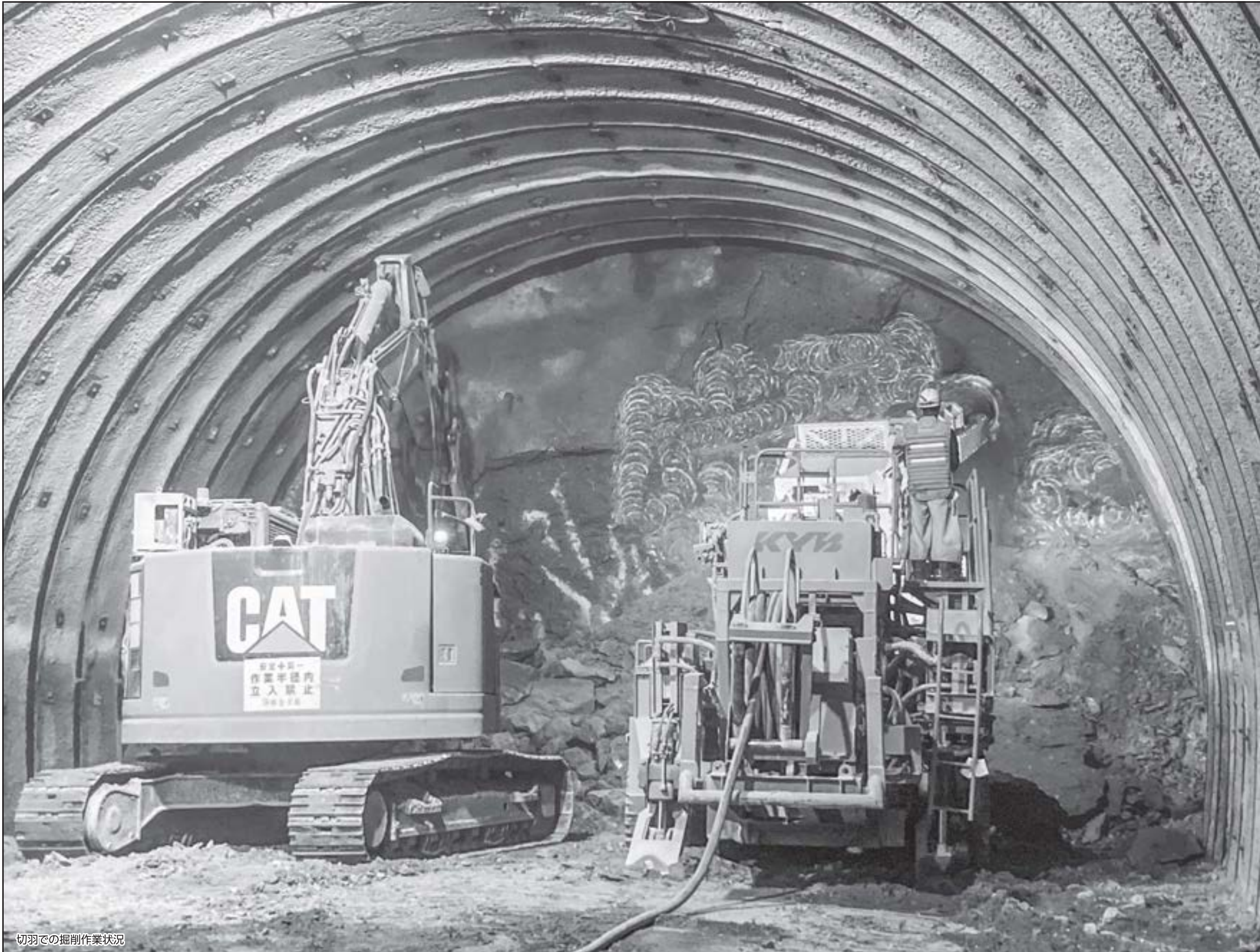
切羽での掘削作業状況
