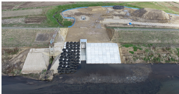
阿武隈川水系内川等災害復旧（新川地区外）樋管（その1）工事
