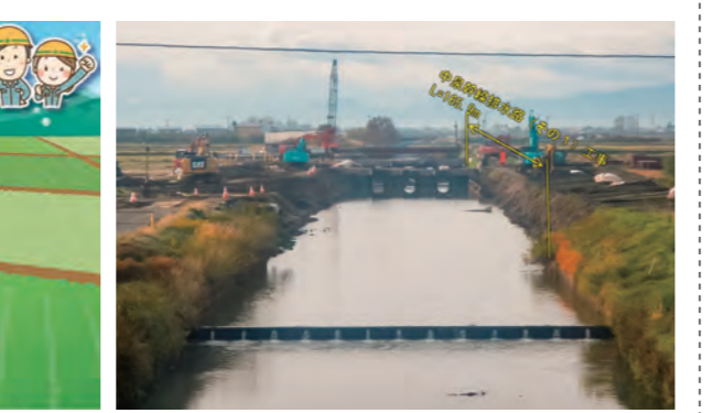
▲施工箇所全景
