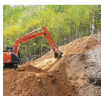
▲切土掘削ICT活用
