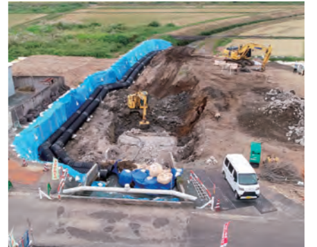
▲横手西部 石持川幹線排水路(その11)工事
