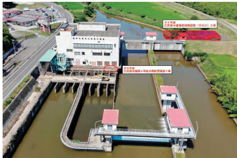
▲角田地区 江尻排水機場
