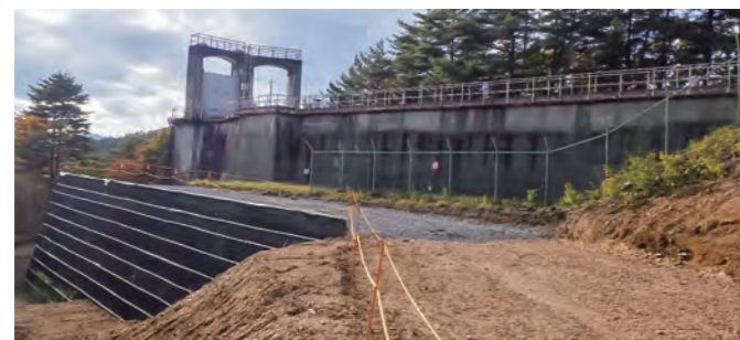
▲来年度補修施工を行う水槽
