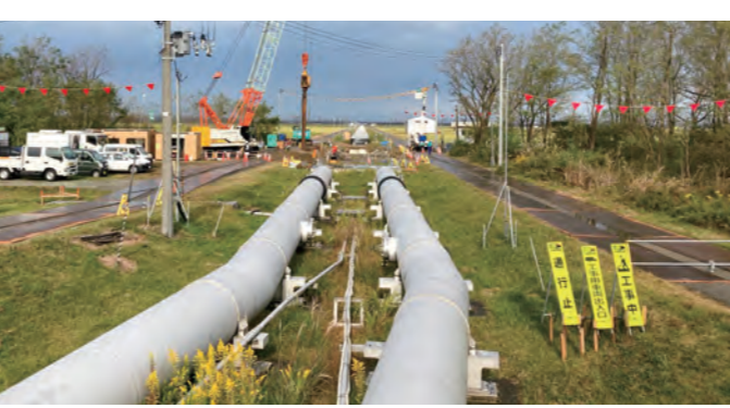
▲現場全景（鋼板打設状況）
