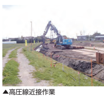
▲高圧線近接作業
