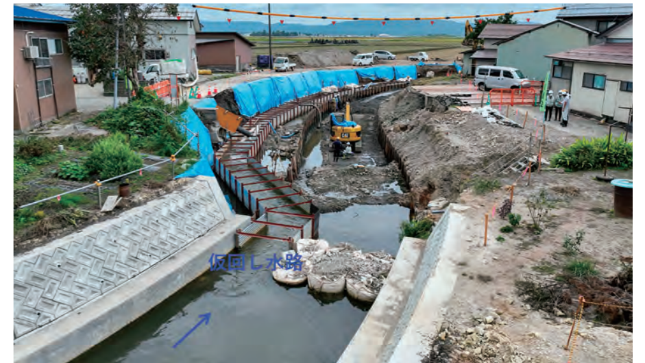
▲横手西部 仮返し水路共用後、水路部掘削状況(R5年度施工範囲)
