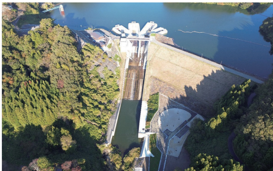
放流部から見たダム本体の全景
