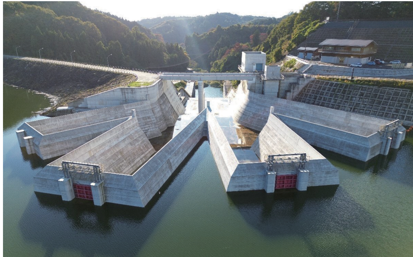
試験湛水が進むダム。4つの越流堰にはラビリンス型を採用した
