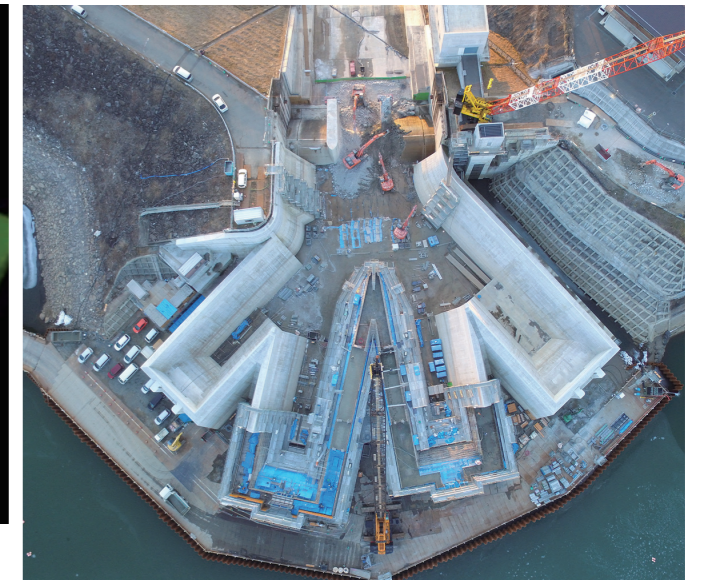
上は3D-CADを用いて施工途中段階を立体化、右は真上から見たラビリンス型をした4つの越流堰の施工の様子
