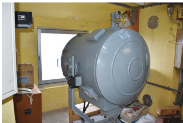
灯室内の照射灯。付近の危険な岩礁を照らす
