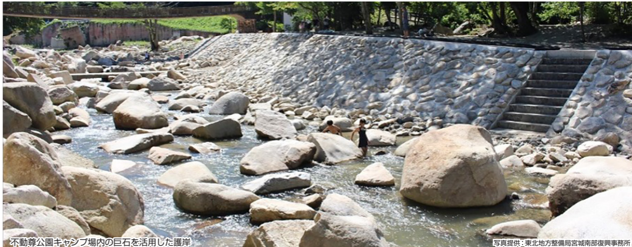
不動尊公園キャンプ場内の巨石を活用した護岸
