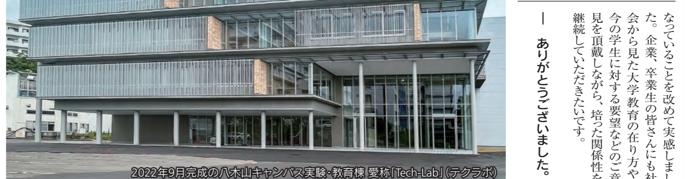
2022年9月完成の八木山キャンパス実験・教育棟「Tech-Lab」(テクラボ)
