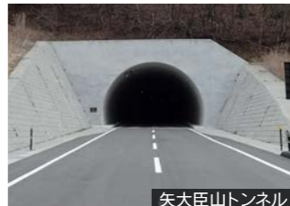
矢大臣山トンネル
