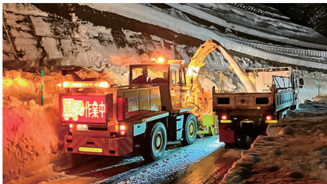
■雪底処理状況
