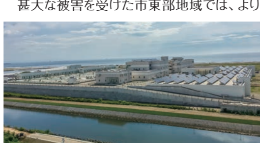
▲復旧後の南蒲生浄化センター。右側には太陽光パネルが見える
