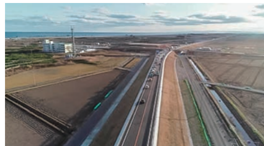
▲多重防御のなめらかなかさ上げ道路
