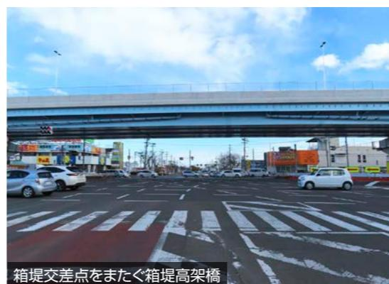
東北地方整備局が事業を進めている「国道4号 仙台拡幅」のうち、箱堤高架橋が完成し、同橋を含む仙台市若林区卸町～宮城野区苦竹の延長1.4kmが、あす(8日)午前5時に立体交差点へ交通を切り替える。同区間では朝ピーク時に箱堤交差点を先頭として最大6km以上の渋滞が発生するなど、ボトルネックとなっていた。このため、2019年度から渋滞対策として拡幅事業(箱堤交差点立体化)に着手。国道4号の本線上に橋長285mの箱堤高架橋を整備し、立体化した。今回の交通切り替えにより、渋滞の改善による事故の減少、また走行環境の改善による物流の効率化が期待される。
