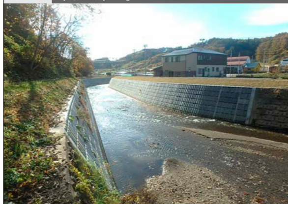
工事名 一級河川北上川筋川原木地区河川改修 (その6) 工事
