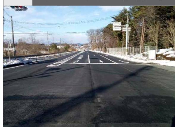
工事名 一般国道282号大更地区舗装補修工事
