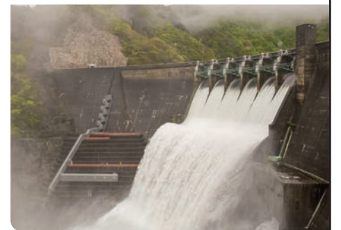
▲湯田ダムクレストゲートからの放流
