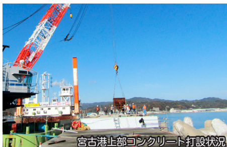
宮古港上部コンクリート打設状況
