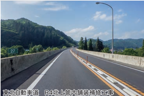
東北自動車道 R4北上管内舗装補修工事
