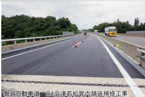
磐越自動車道 R4会津若松管内舗装補修工事
