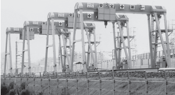
■橋型クレーン
