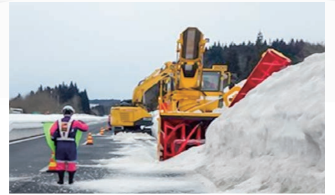
■路肩拡幅状況
