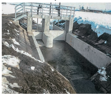
▲改修後 内面補修または補強
