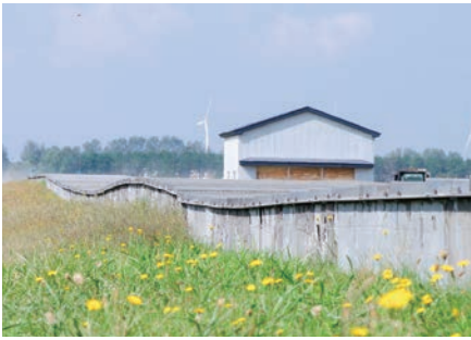
▲施工前(幹線用水路の不同沈下の状況)
