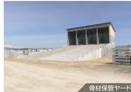
骨材保管ヤード
