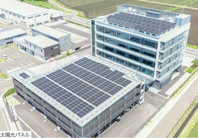
太陽光パネル
