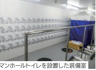
マンホールトイレを設置した装備室
