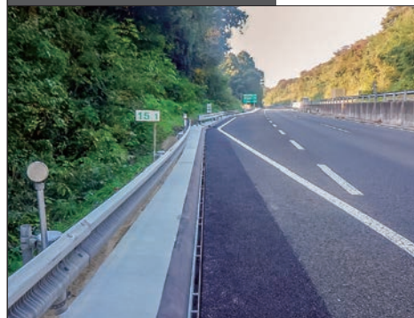
優良建設工事施工業者表彰 仙台松島道路 路肩構造改修工事
