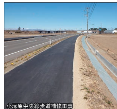
小塚原中央線歩道補修工事
